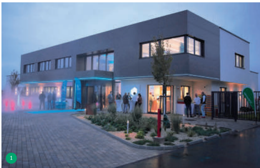
1 Das neue Fachkompetenzzentrum für Bewässerung in Österreich, die Waterworld von PARGA.
